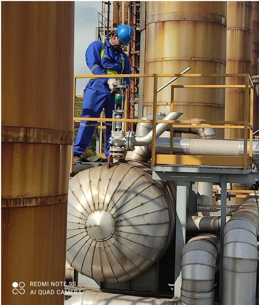
Equipo auxiliar de alza para certificación del set de las válvulas de seguridad
